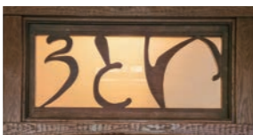
▲ひのきの一枚板をくり抜いた、いとう呉服店の「いとう」の文字。
