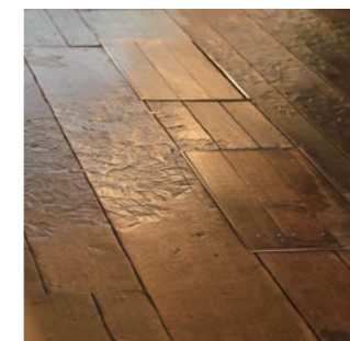
【食堂】違う幅の板でデザインされ、名票が施された床は、当時では珍しい床暖房が設けられていた。
